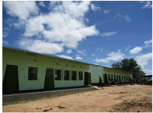
完成した校舎
