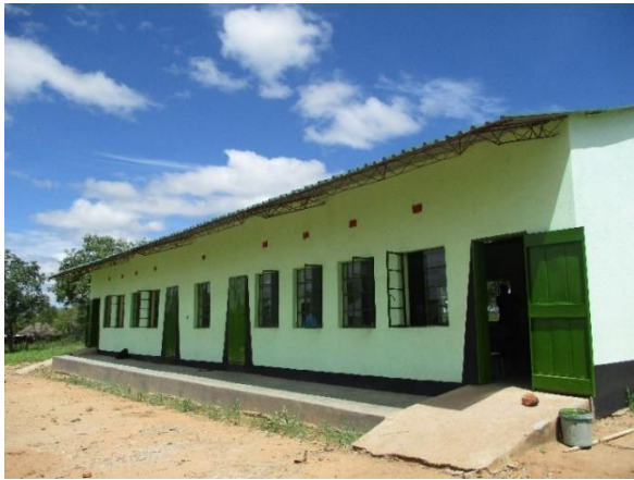
完成した校舎
