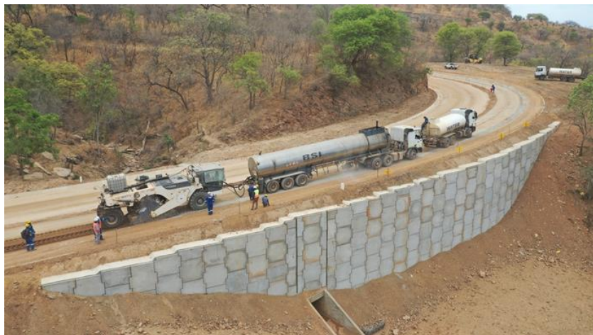
道路工事中の状況
