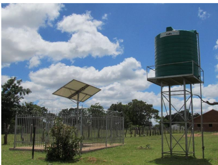
事業により設置されたソーラーポンプと水道
