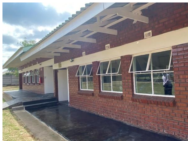
建設された教室棟
