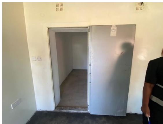
教室棟内に建設された貴重品室
