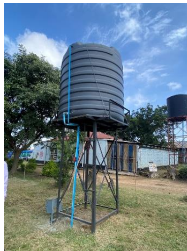
設置した井戸の水を貯める水タンク
