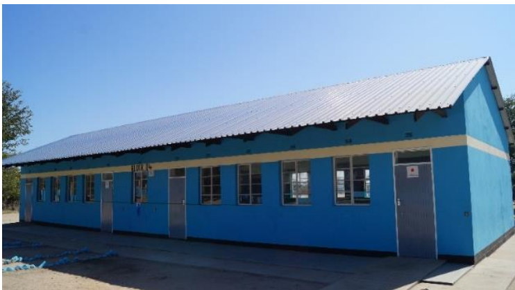
建設された教室
