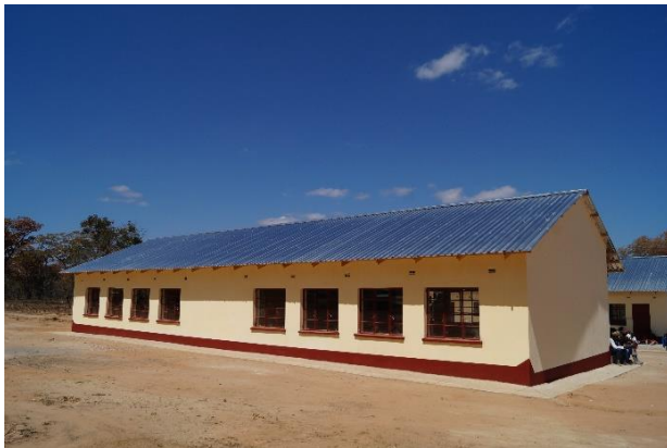
建設された教室棟
