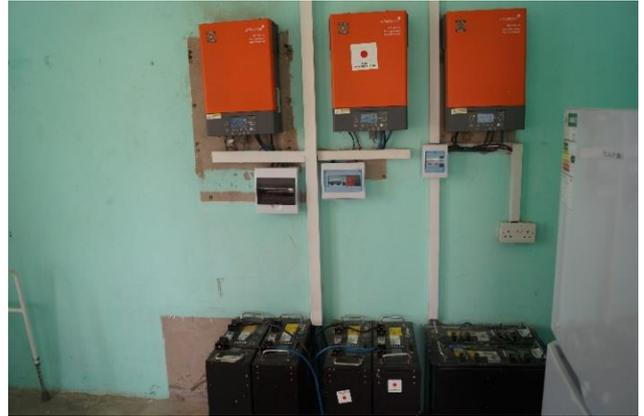
電気を貯めるためのインバーターとバッテリー
