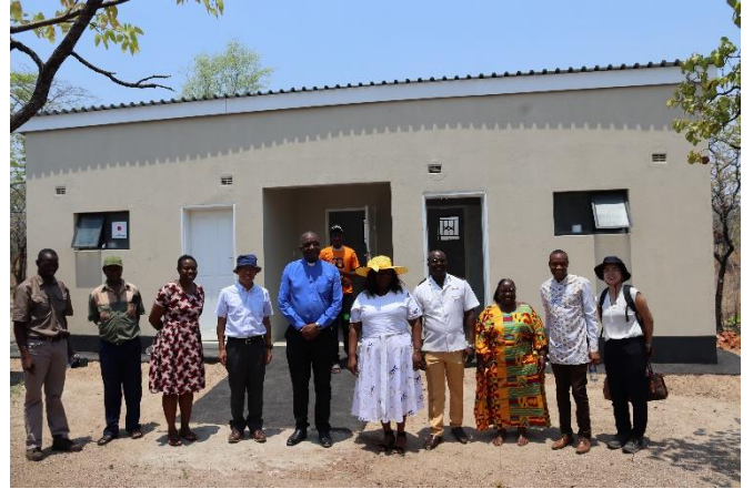
建設されたトイレ棟
