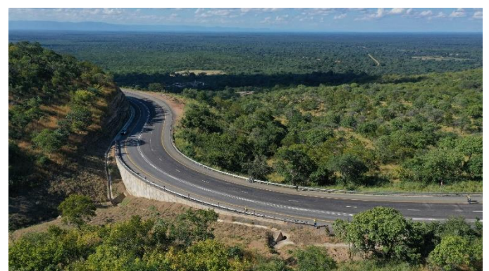
第一次道路改修区間
