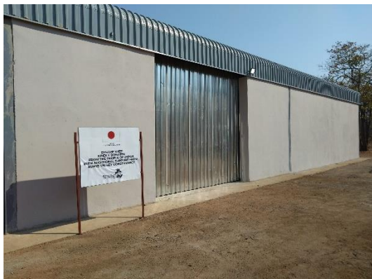
本案件で整備した鉄骨造りの倉庫
